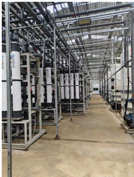
电解金属锰新建含锰废水回收处理系统项目实景图
