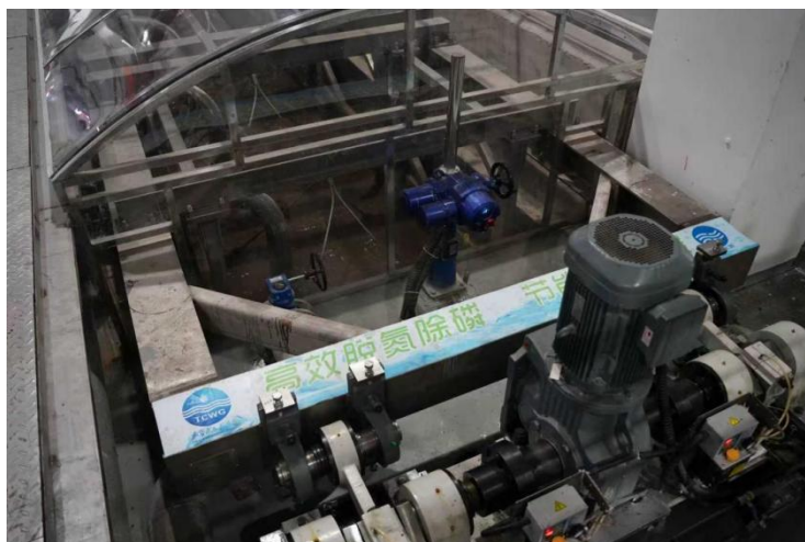
江苏太仓市城东水质净化厂低能耗振动 MBR 工艺单元
